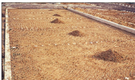
Riempimento degli alveoli con terreno vegetale. Alveoluses filled with vegetable ground.
