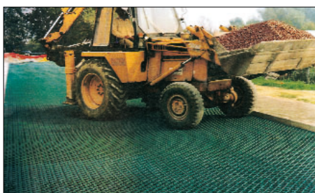
L'immediata carrabilità agevola le operazioni di finitura. Prompt carriageability helps finishing operations.
